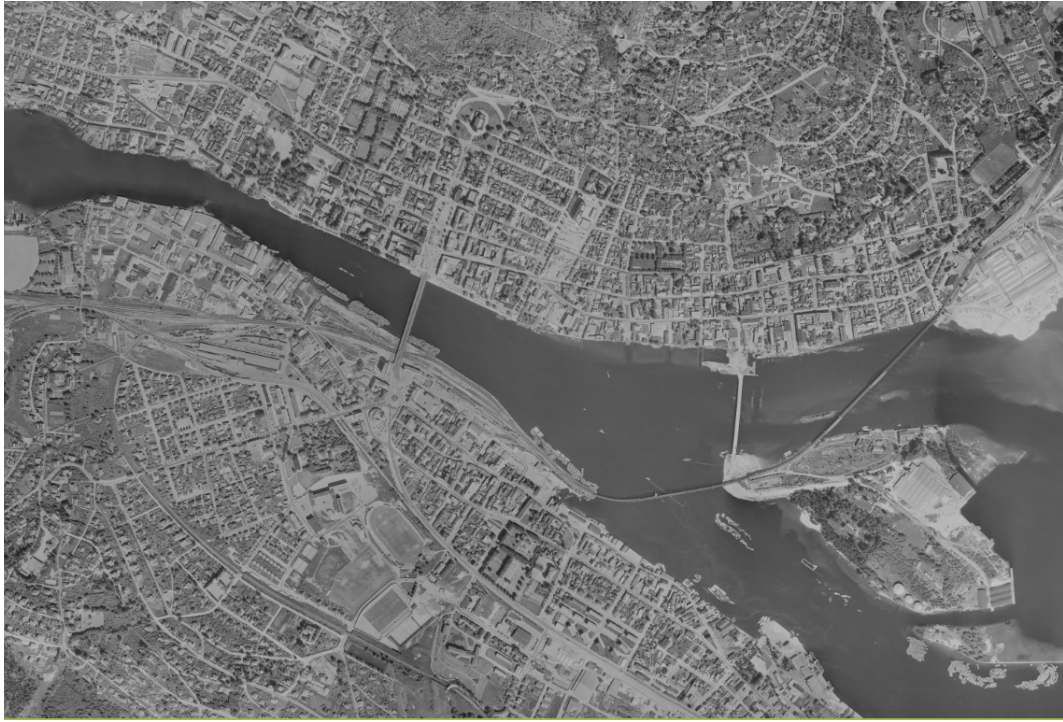
Figur 3. Det sentrale Drammen i 1963. Fortsatt er Bybrua riksveiforbindelsen mellom Oslo og Vestfold/Sørlandet. [Kilde: Statens kartverk – Geovekst-luftfoto 21.7. 1963]
