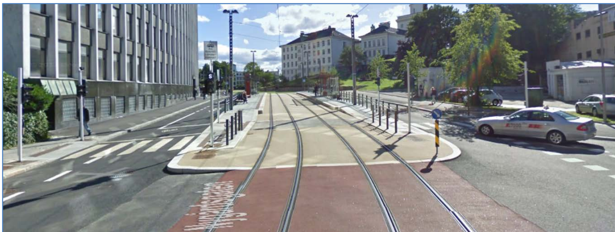
Figur 18 Nygårdsgaten holdeplass på midtstilt kollektivtrasé, Bybanen Bergen. Foto: Google maps
