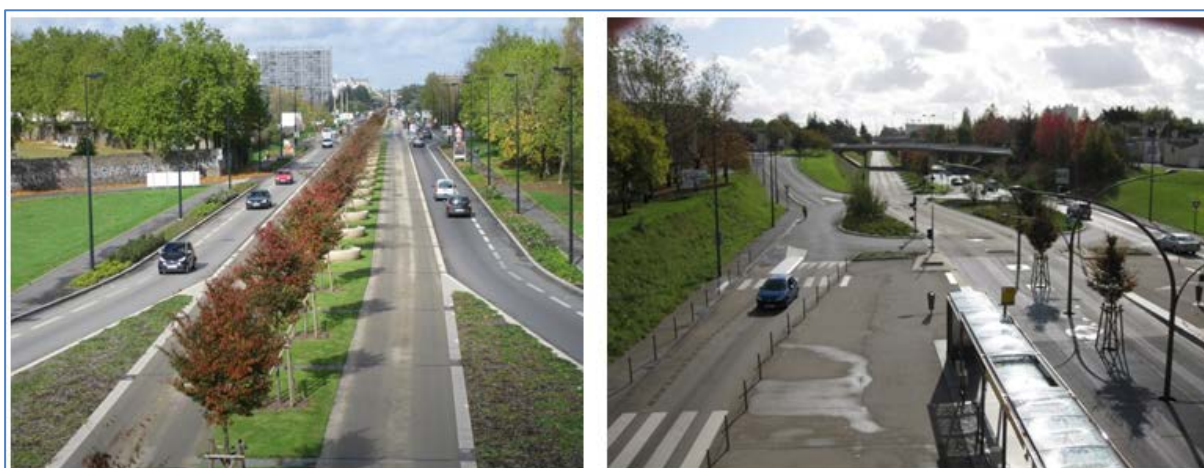
Figur 7 Midtstilt kollektivfelt og kollektivgate, Nantes. Foto: Statens vegvesen
