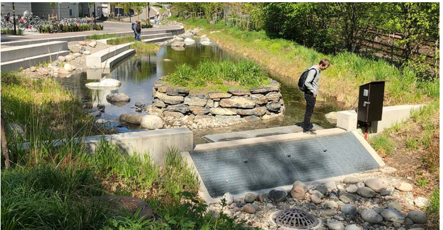
Gaustadbekken, Frognerelva ved Forskningsparken, anlagt i 2016.
