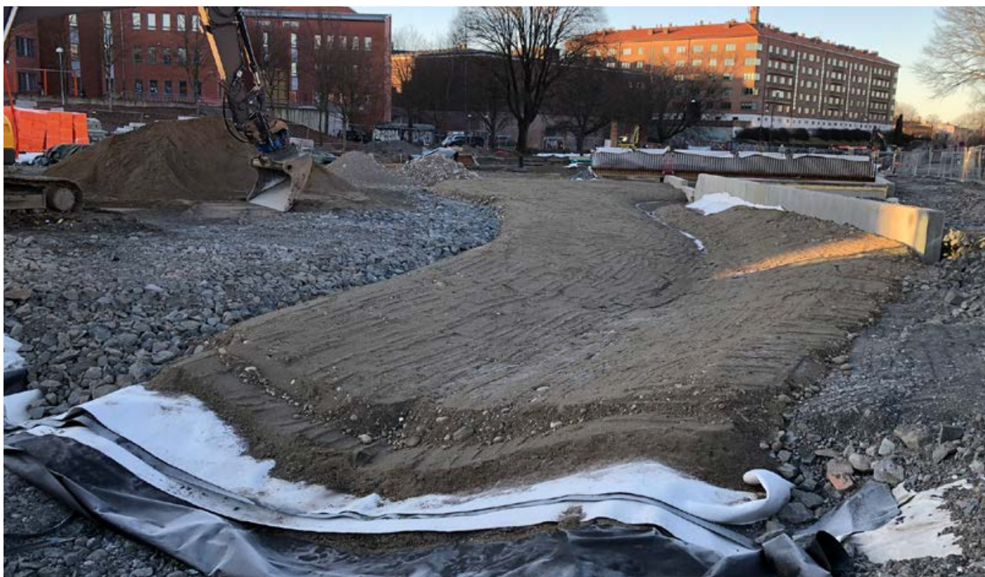
Etablering av tett bekkébunn med membran. Hovinbekken, Jordal.
