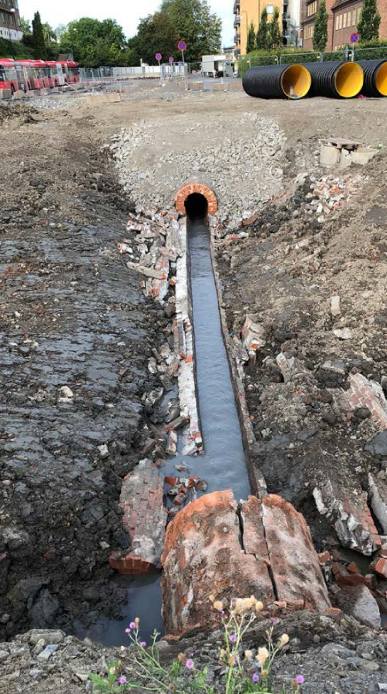
Helsfyrbekken på Jordal, overhvelvet med teglstein.
