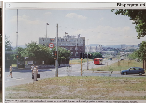
Bispegata i 1997: En tofelts bygate, tilrettelagt også for gang- og sykkeltrafikk. I påvente av det endelige gatekøp, er resten av den tidl. veibanen midlertidig beplantet. Miljøbyens rolle: Generell deltager, synliggjøring. Ansvarelig utbygger: Statens vegvesen Oslo
